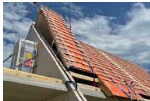
SlimFix XT Prefab daksegmenten (nieuwbouw)
