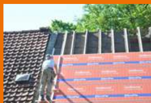
SlimFix Spoor voor sporenkappen (renovatie)
