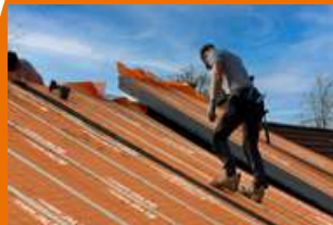
SlimFix Reno Multi voor op een dragend dakbeschoot (renovatie)
