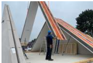
SlimFix XT Max Prefab dakelementen (nieuwbouw)
