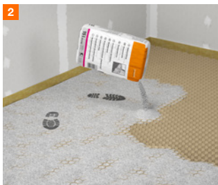
2 Het fermacell™ Honingraatelement met fermacell™ Honingraatkorrels vullen
