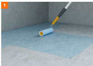
1 Ondergrond gronderen en randstroken aanbrengen
