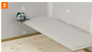
Afzagen van liplas voor eerste rij platen
