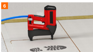
...bevestigen met spreidnieten
