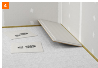
Leggen van de vloerelementen
