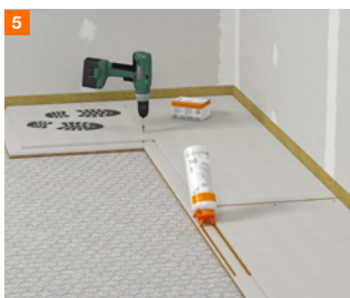
5 Het bevestigen van de fermacell® Vloerelementen
