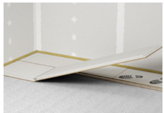
Leggen van de vloerelementen
