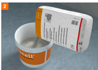
2 Zakgoed in emmer strooien cf. verwerkingsrichtlijn
