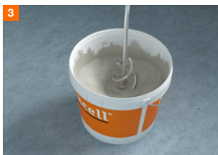
3 In een schone emmer mengen 6,5 l water per 25 kg
