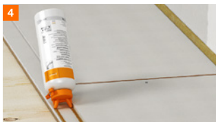
Aanbrengen lijm
