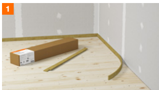
Aanbrengen randstrook
