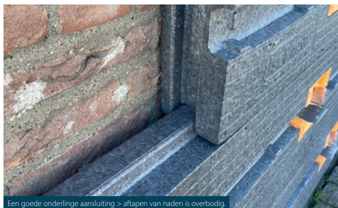
Een goede onderlinge aansluiting > aftapen van naden is overbodig.
