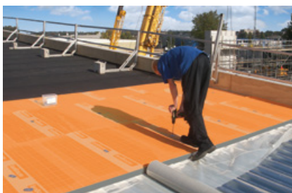
Plat dak isolatie
