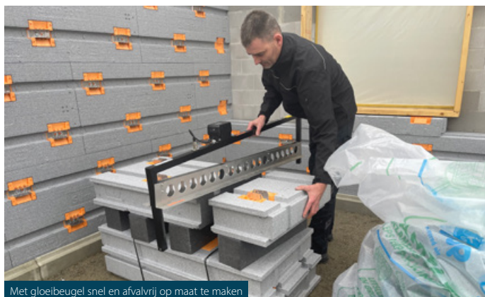
Met gloei-beugel snel en afvalvrij op maat te maken
